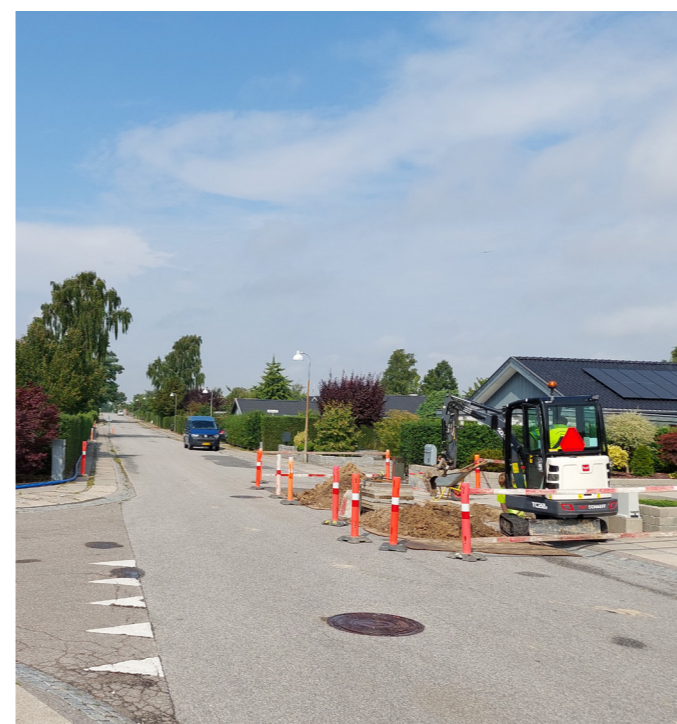
Ledningsrenovering på Flådevej 2022.
