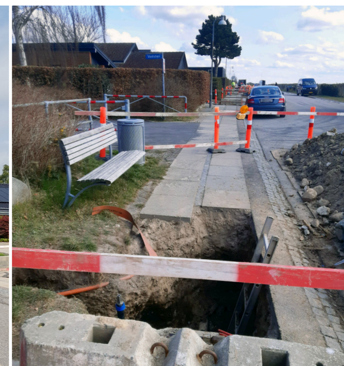
Ledningsrenovering på Snekkevej 2022.
