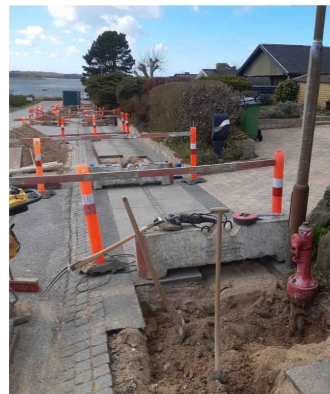
Ledningsrenovering på Snekkevej.
